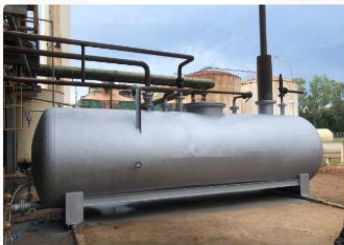
Jateamento e pintura do tanque de condensado
