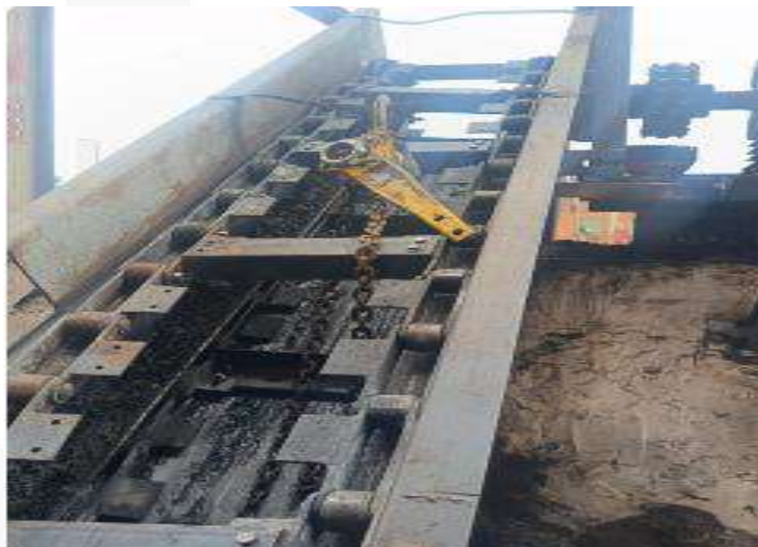
Troca das Palhetas do redller de cinza da caldeira
