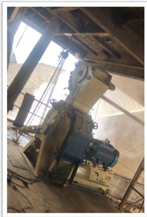
Iniciando a Instalação do Moinho de Farelo
