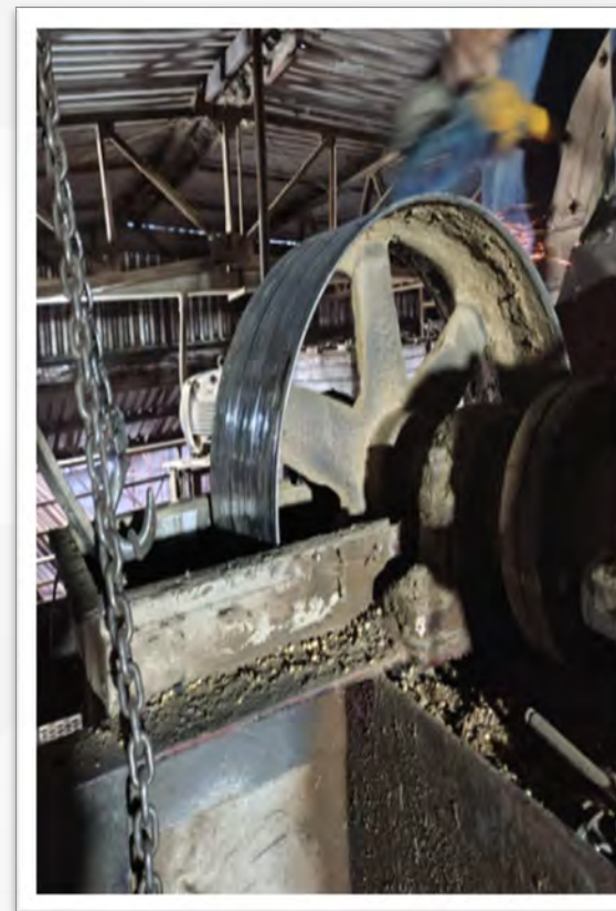
Tambor do Elevador 03, Sendo emborrachado
