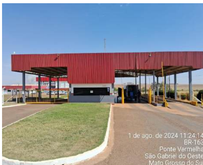
Foto: Unidade Frigorifica "em obra de ampliação" (Alugada para Boibras Ind.)
