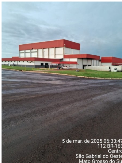
Foto: Unidade Frigorífica (Alugada para Boibras Ind.)
