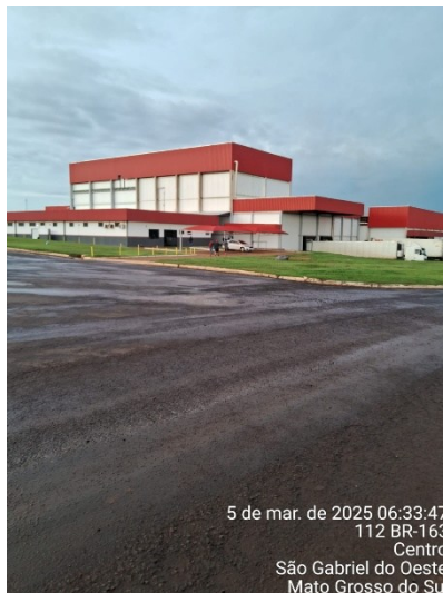
Foto: Unidade Frigorífica (Alugada para Boibras Ind.)
