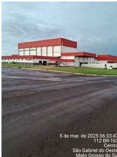
Foto: Unidade Frigorífica (Alugada para Boibras Ind.)
