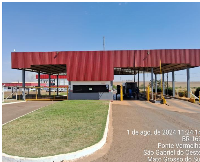
Foto: Unidade Frigorífica "em obra de ampliação" (Alugada para Boibras Ind.)
