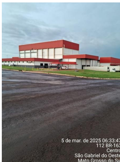
Foto: Unidade Frigorífica (Alugada para Boibras Ind.)
