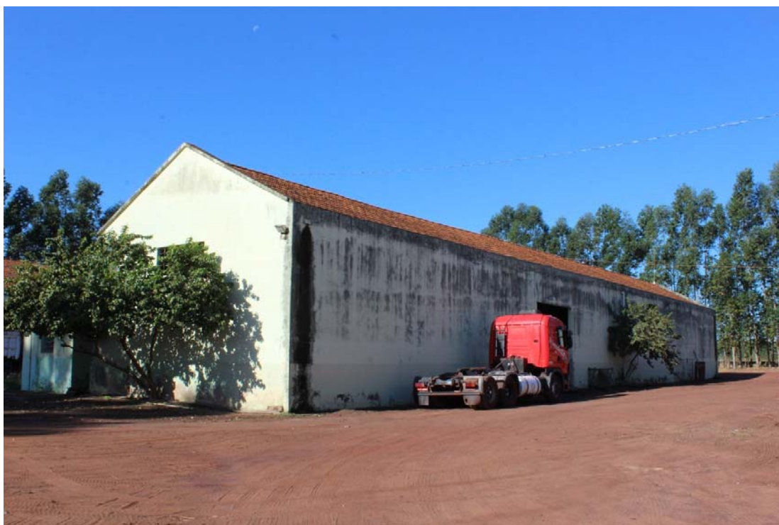
Fotografia 06 – Aspecto geral do imóvel avaliado e suas construções e benfeitorias – Galpão apoio a oficina.
