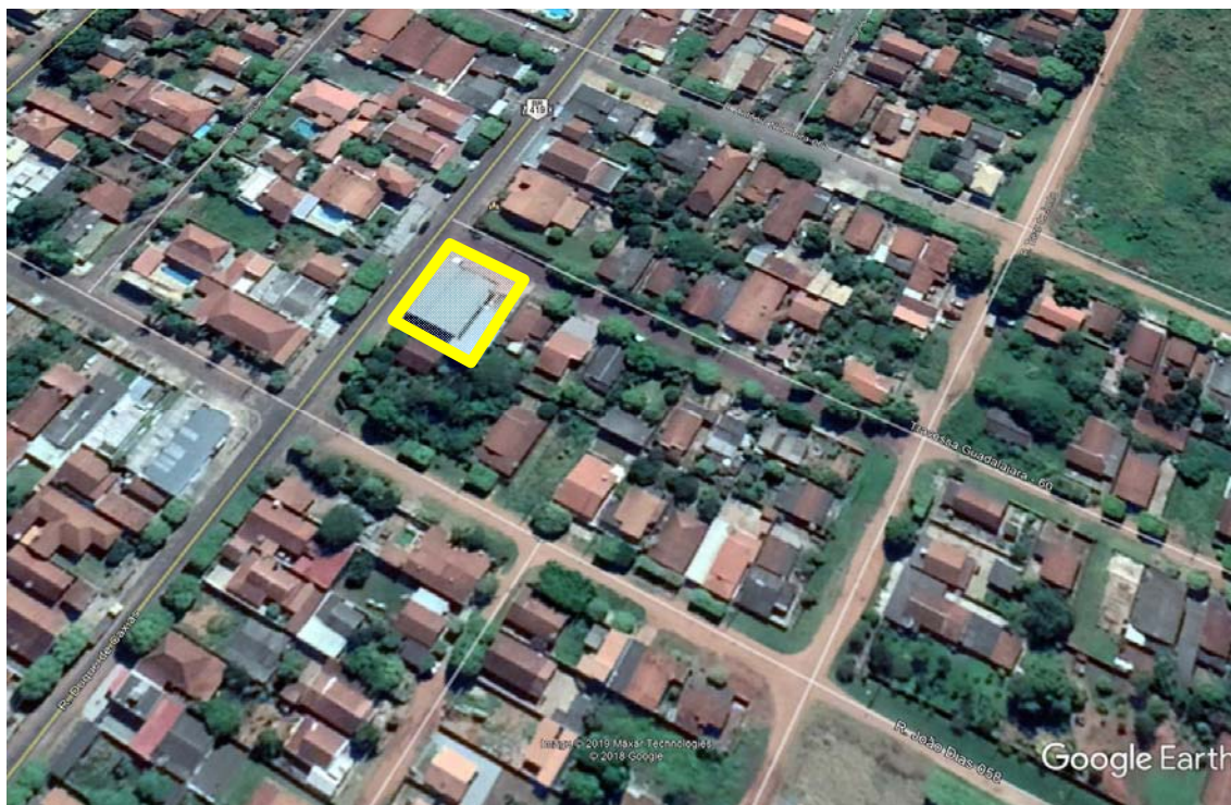
Fotografia 01 – Localização do imóvel (em amarelo) em relação á quadra formada pela Rua Duque de Caxias, Travessa Guadalajara, Rua João Dias e Rua Treze de Junho.
