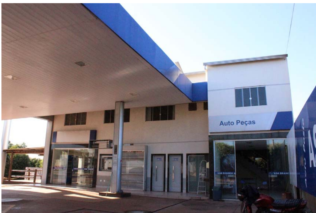
Fotografia 04 – Aspecto geral do imóvel avaliado, suas construções e benfeitorias – Administração, Auto Peças, Banheiros e Lanchonete.
