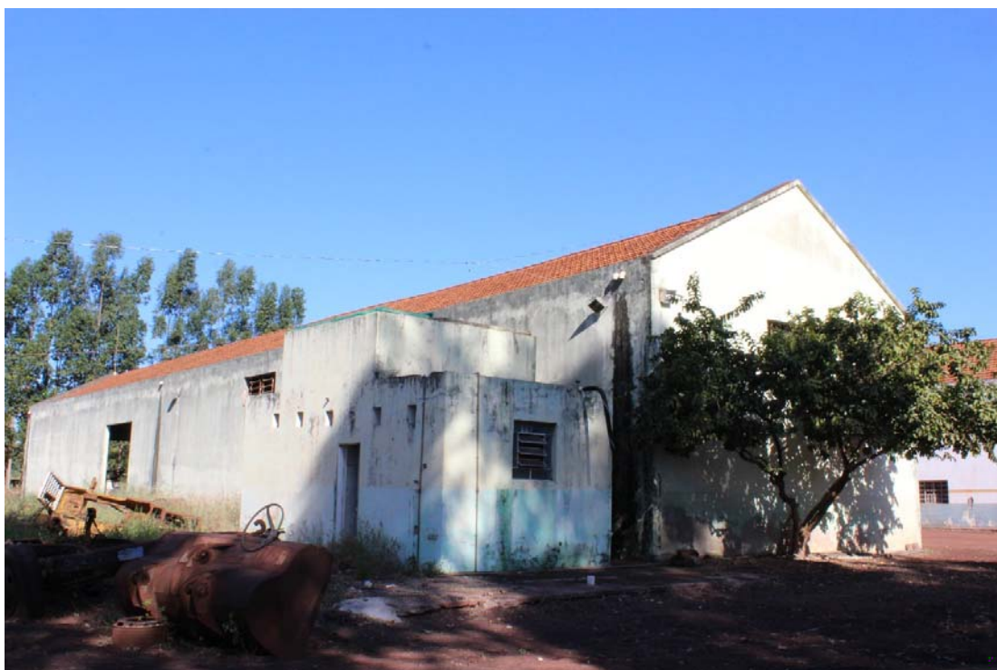
Fotografia 07 – Aspecto geral do imóvel avaliado e suas construções e benfeitorias – Galpão apoio a oficina.
