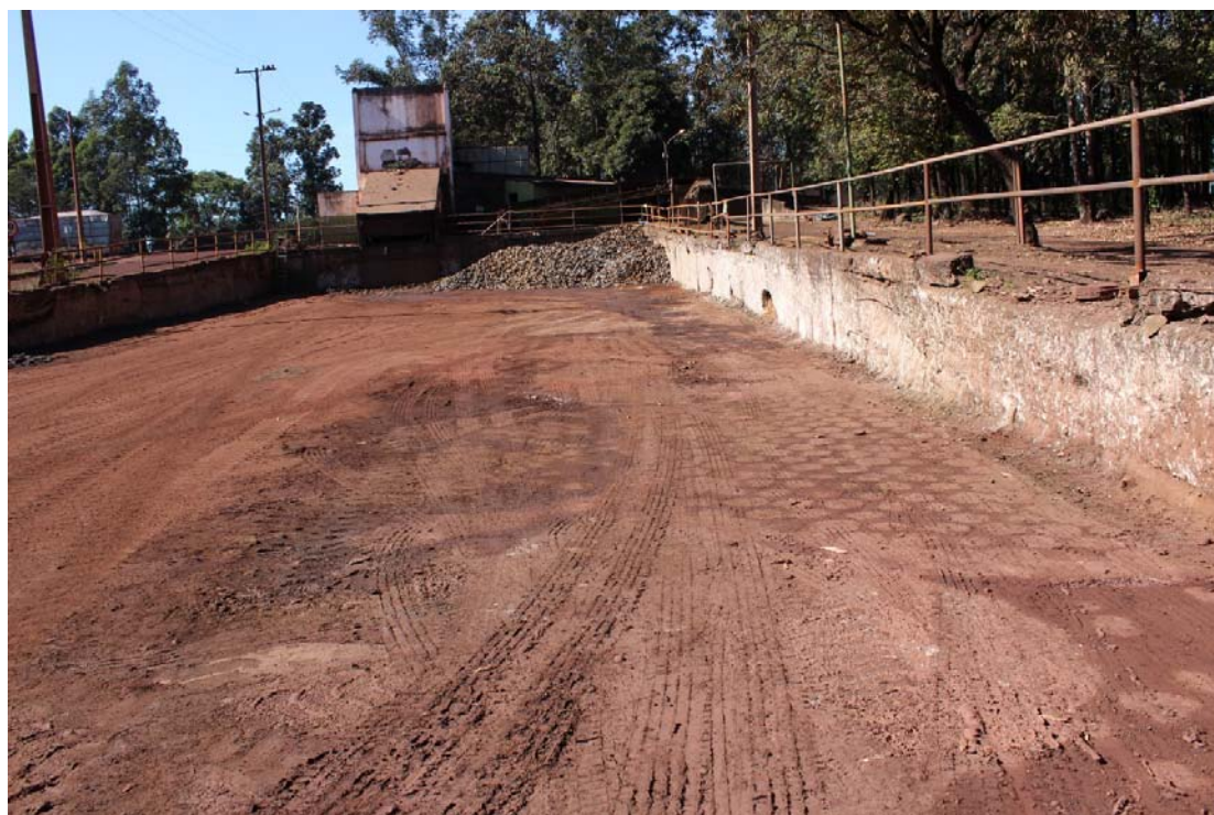
Fotografia 07 – Aspecto geral do imóvel avaliado e suas construções e benfeitorias.
