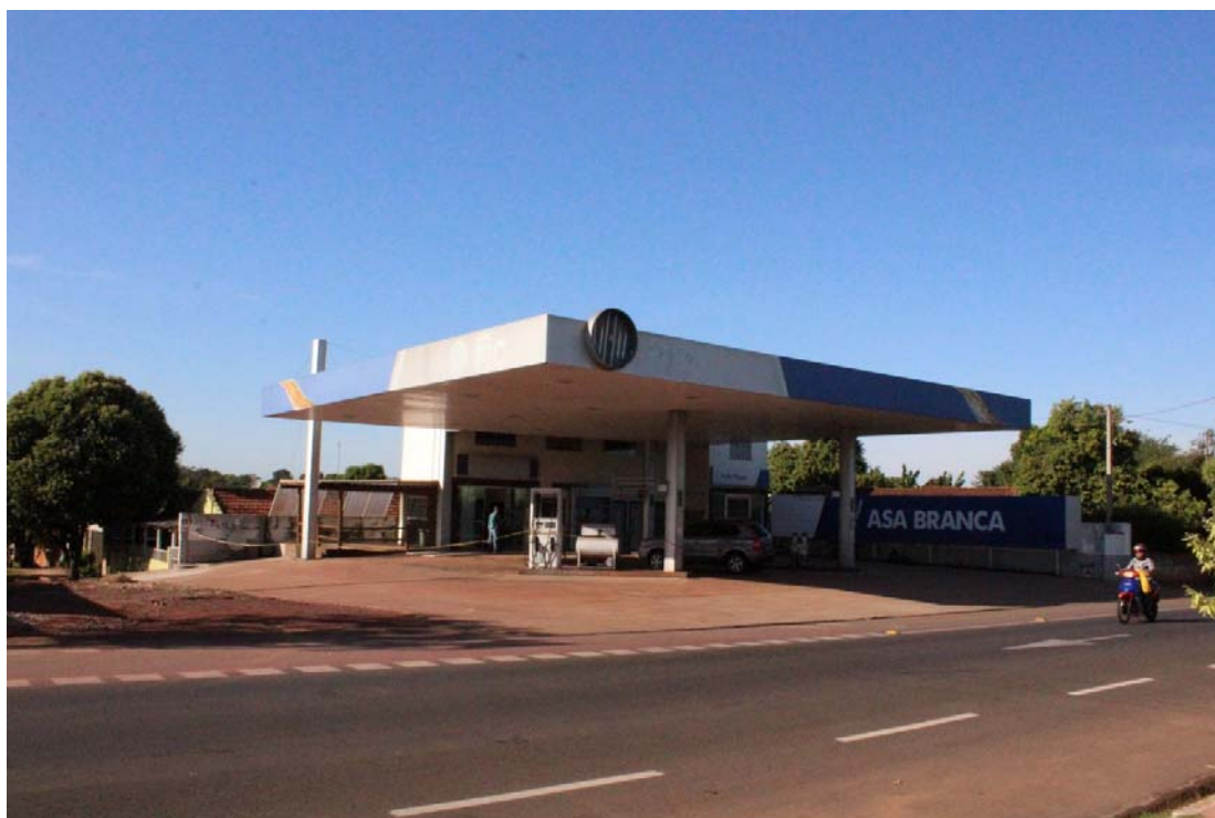
Fotografia 02 – Aspecto geral do imóvel avaliado, suas construções e benfeitorias – Frente do Posto.
