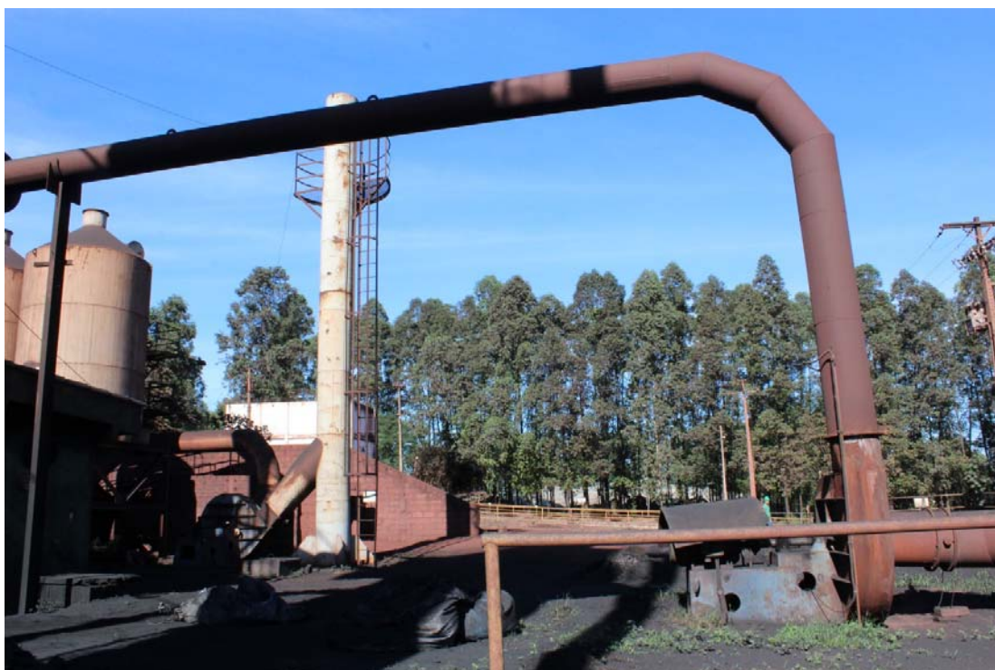
Fotografia 05 – Aspecto geral do imóvel avaliado e suas construções e benfeitorias.
