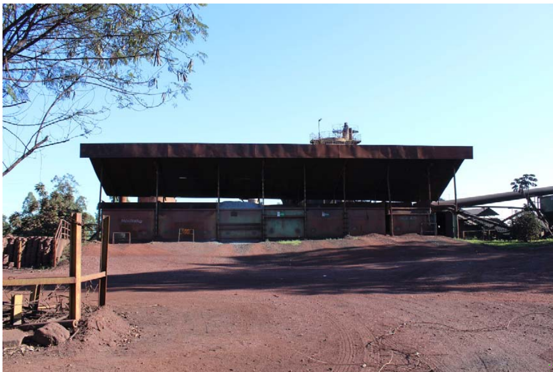
Fotografia 04 – Aspecto geral do imóvel avaliado e suas construções e benfeitorias.
