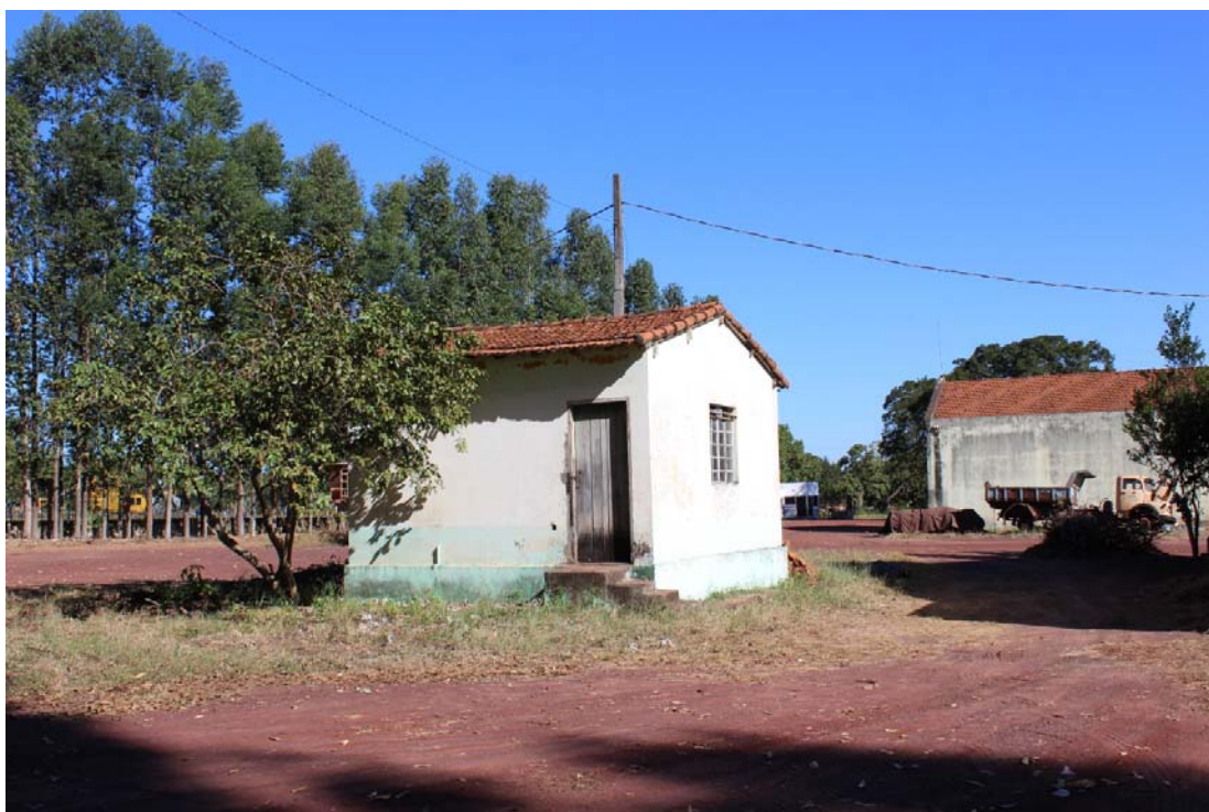
Fotografia 03 – Aspecto geral do imóvel avaliado e suas construções e benfeitorias – Casa de Apoio.
