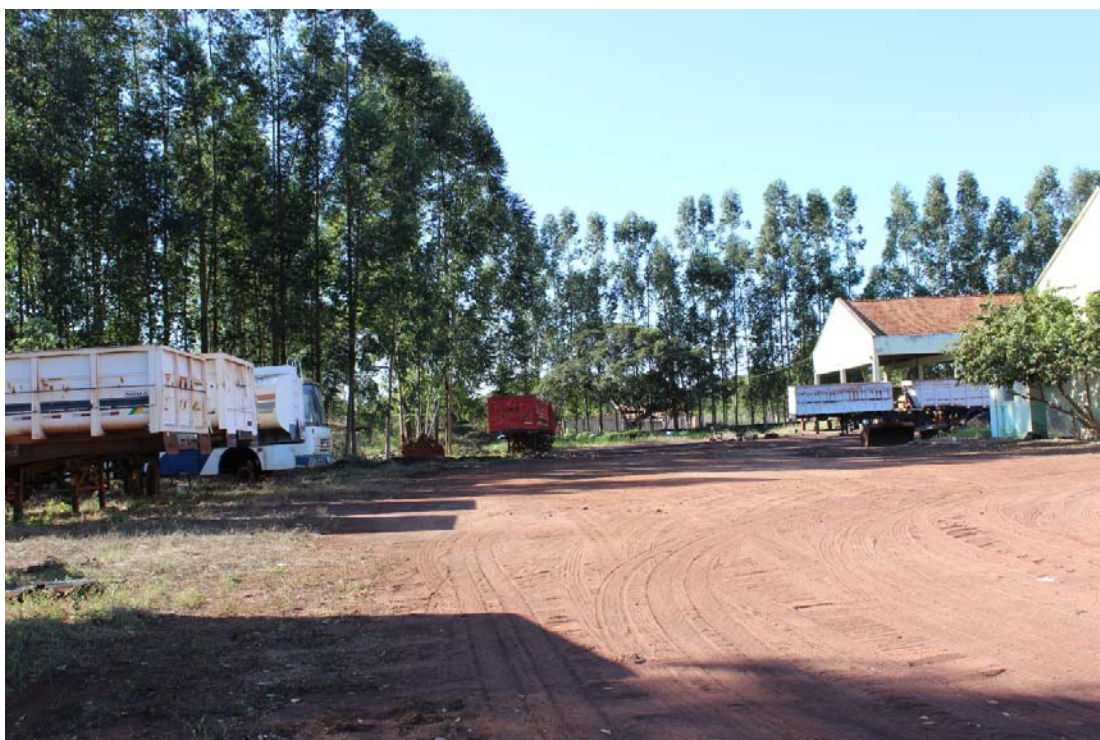
Fotografia 08 – Aspecto geral do imóvel avaliado e suas construções e benfeitorias – Pátio de Manobra.
