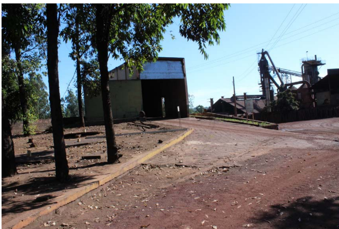
Fotografia 09 – Aspecto geral do imóvel avaliado e suas construções e benfeitorias.
