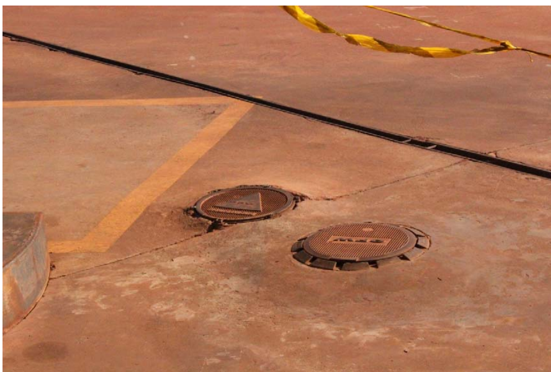
Fotografia 06 – Aspecto geral do imóvel avaliado, suas construções e benfeitorias – Acesso tanque de combustível.
