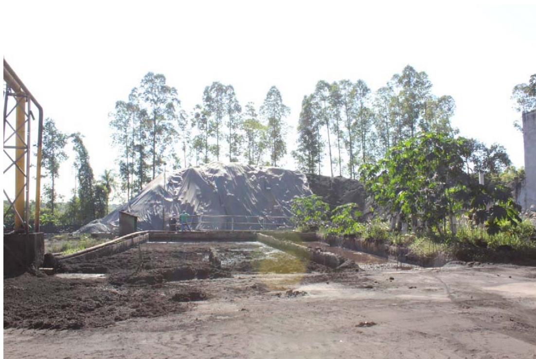
Fotografia 06 – Aspecto geral do imóvel avaliado e suas construções e benfeitorias.
