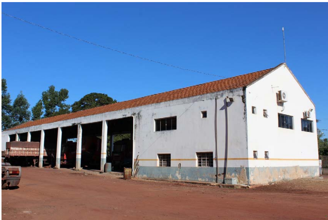
Fotografia 05 – Aspecto geral do imóvel avaliado e suas construções e benfeitorias – Galpão Administração e Oficina.
