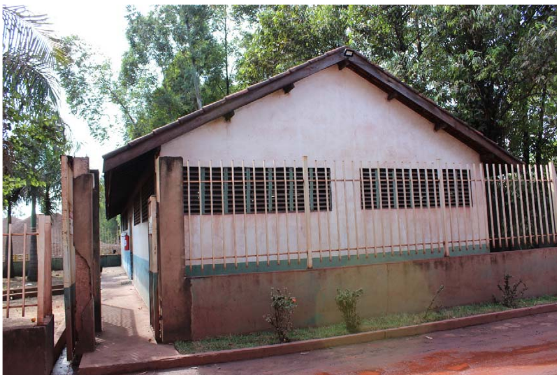
Fotografia 03 – Aspecto geral do imóvel avaliado e suas construções e benfeitorias – Vestiário.
