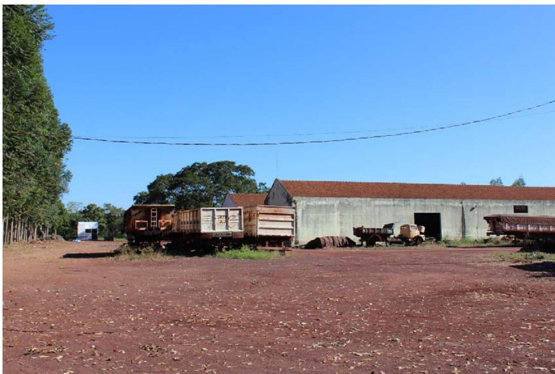
Fotografia 101 – Aspecto geral do imóvel avaliado e suas construções e benfeitorias – Pátio de Manobra.
