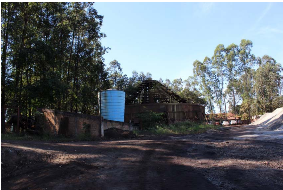
Fotografia 08 – Aspecto geral do imóvel avaliado e suas construções e benfeitorias.
