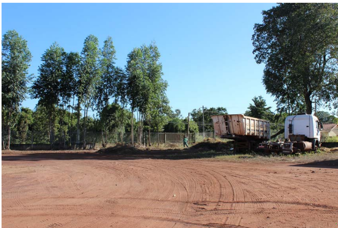
Fotografia 09 – Aspecto geral do imóvel avaliado e suas construções e benfeitorias – Pátio de Manobra.
