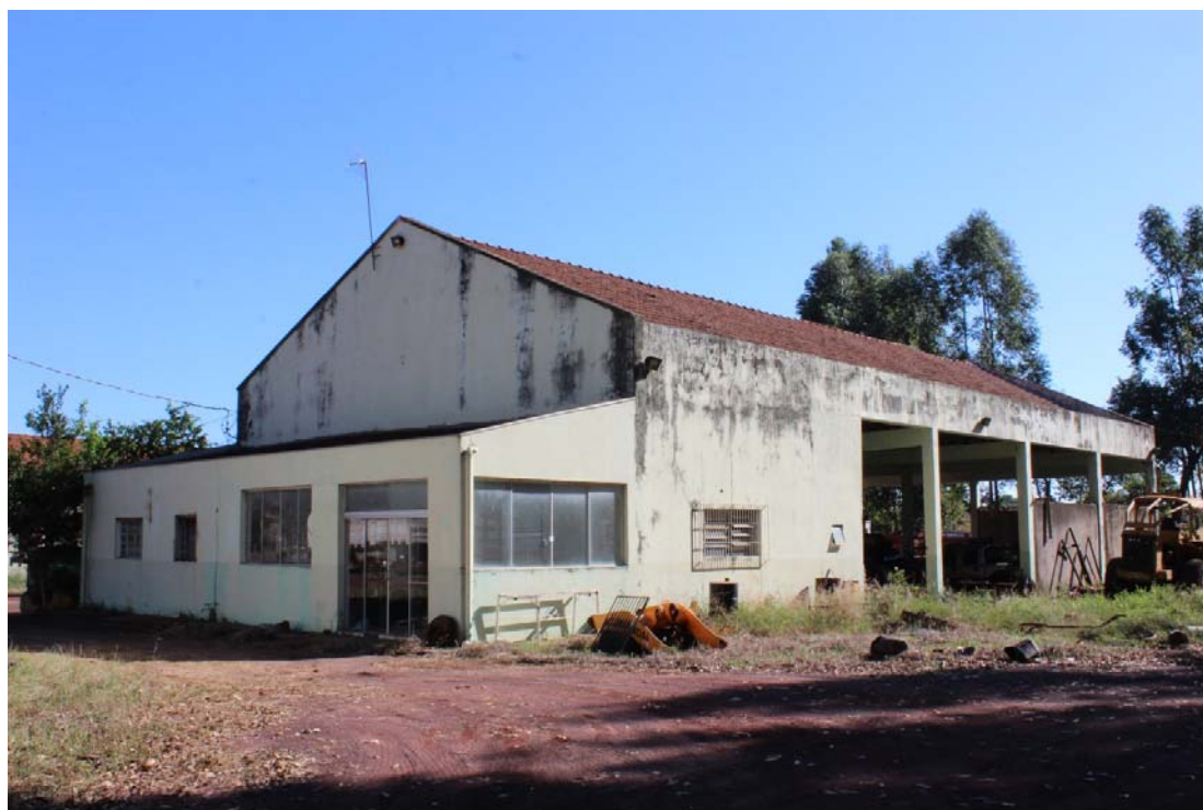
Fotografia 02 – Aspecto geral do imóvel avaliado e suas construções e benfeitorias – Galpão.
