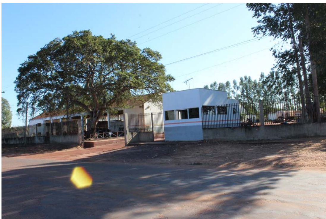
Fotografia 04 – Aspecto geral do imóvel avaliado e suas construções e benfeitorias – Portaria.
