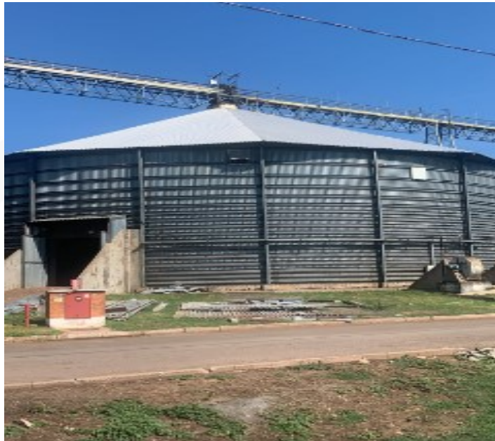
Silo 02 - Vista geral do telhado finalizada
