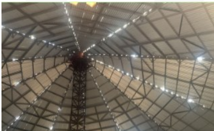
Interior Silo 02 – Montagem da cobertura finalizada
