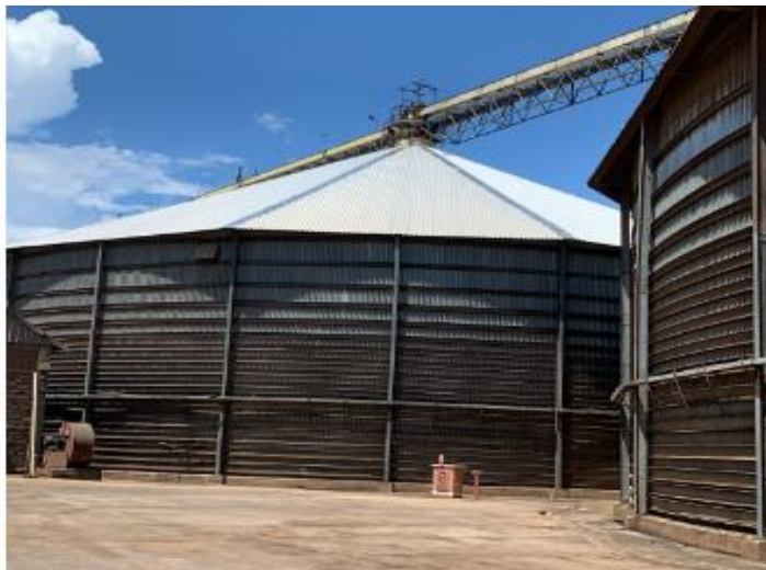
Interior Silo 02 – cobertura finalizada, já com rufo
