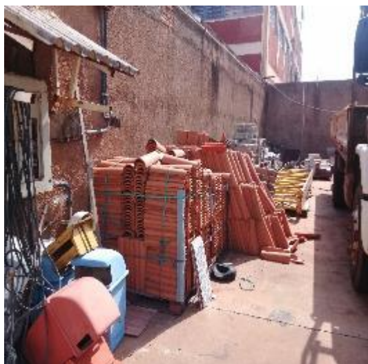
Depósito telhas pátio
