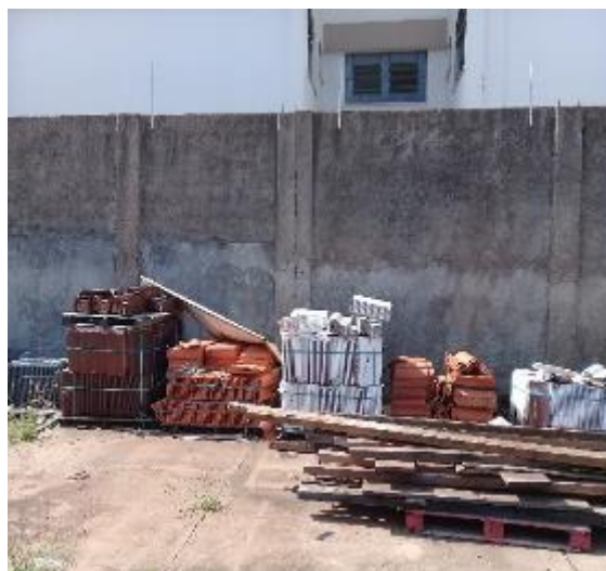
Depósito telhas pátio
