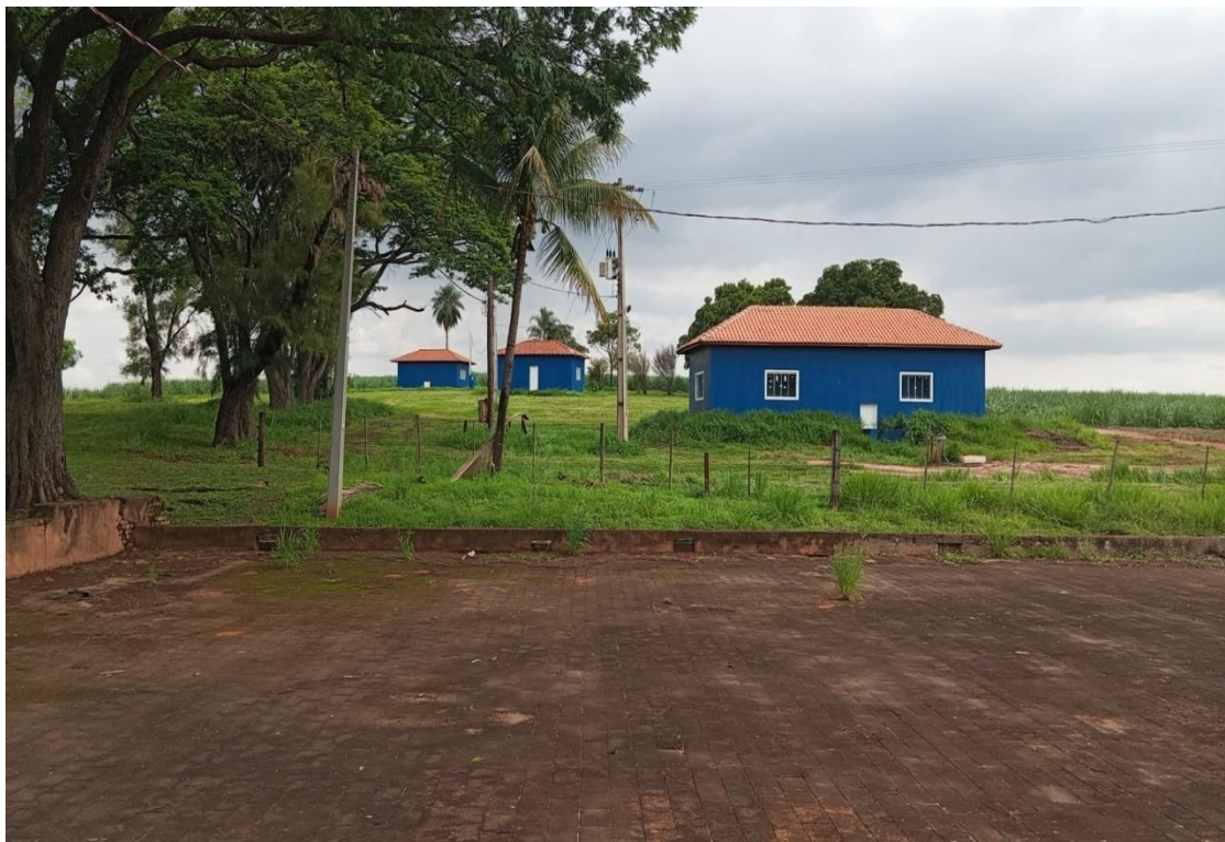
DEPÓSITO DE ÁGUA
