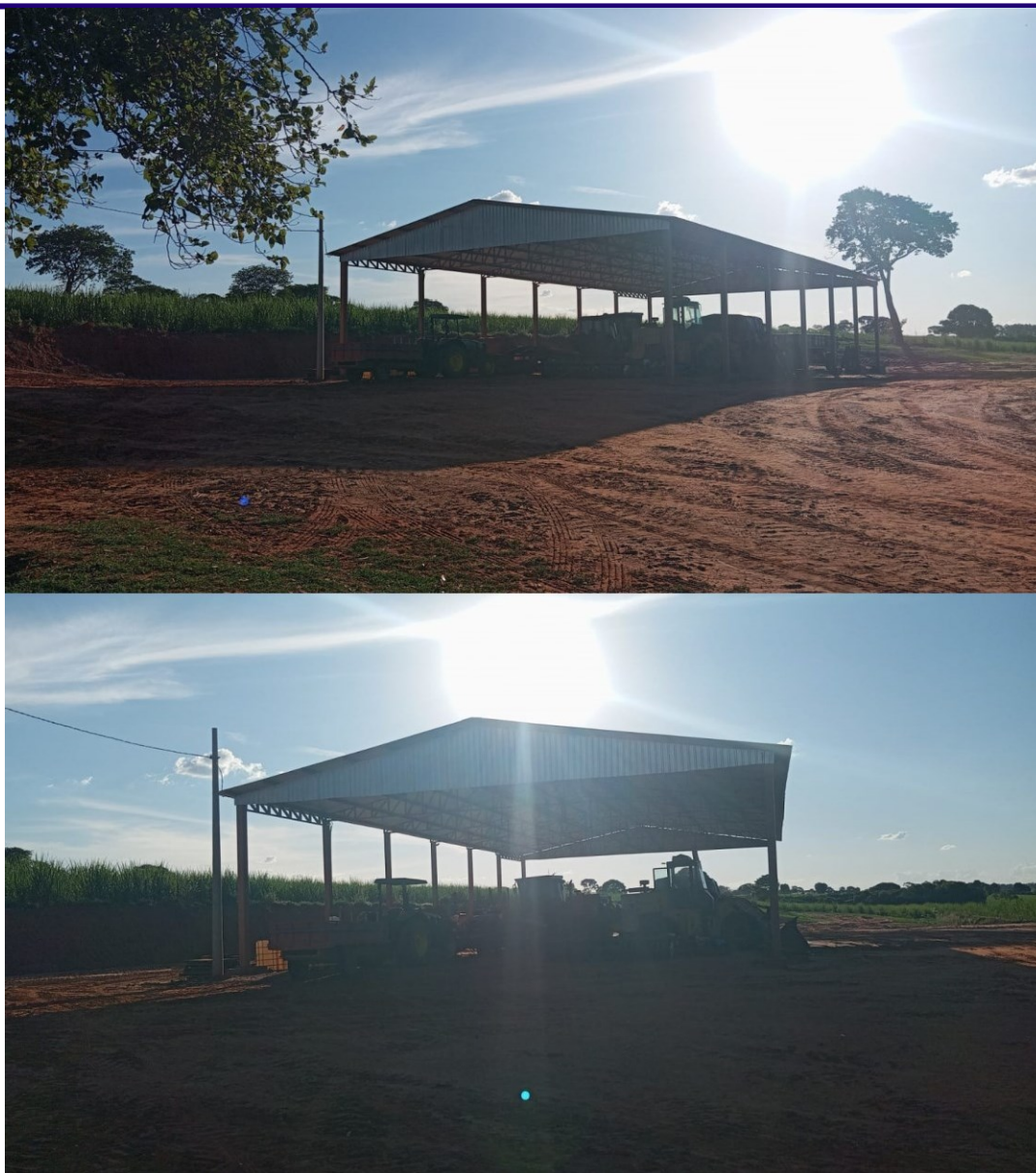
Barracão de Máquinas
