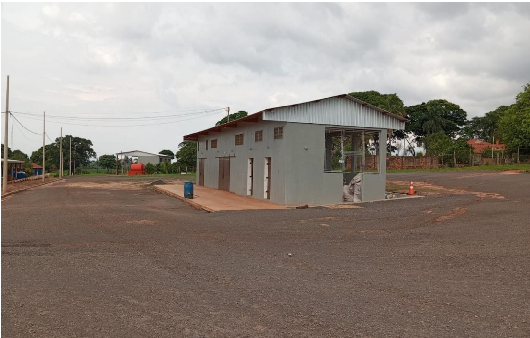
BARRACÃO DE DEFENSIVOS
