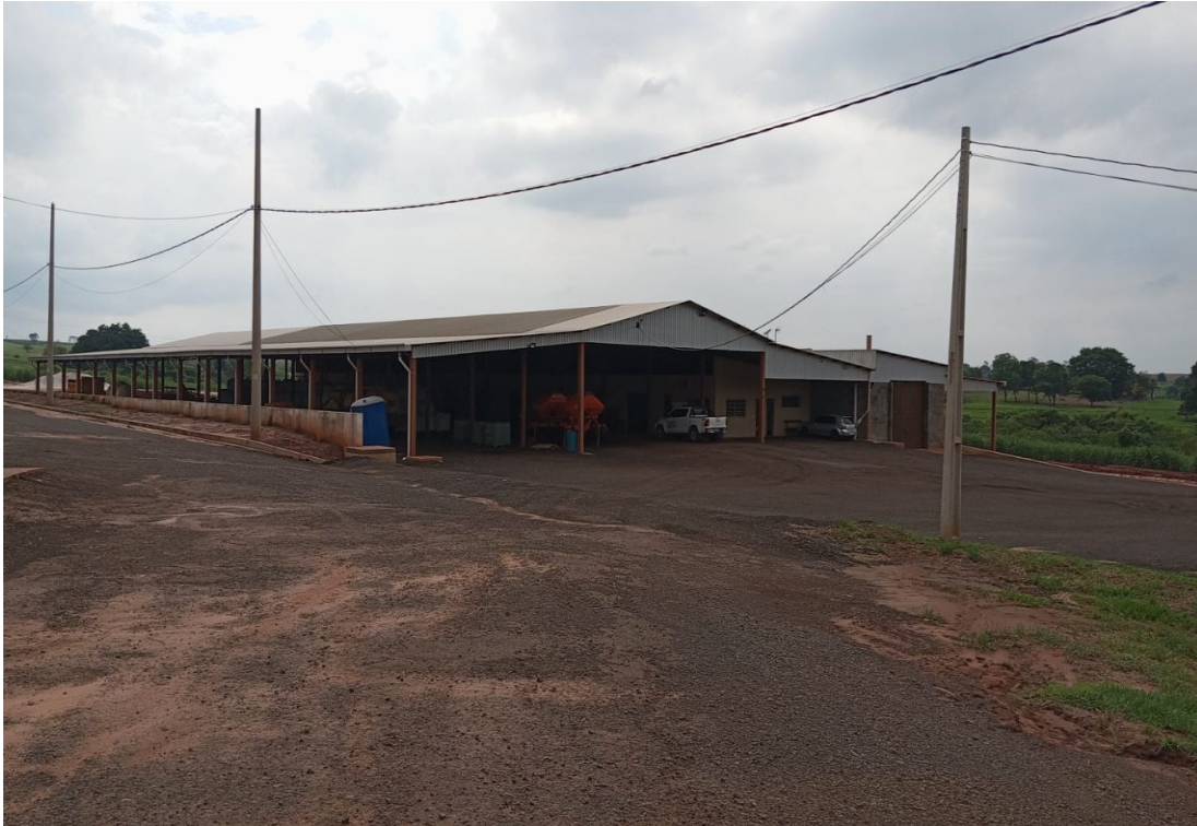
BARRACÃO DE MÁQUINAS
