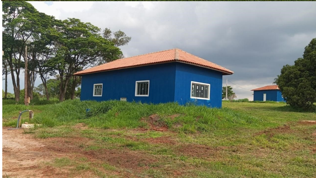
DEPÓSITO DE ÁGUA
