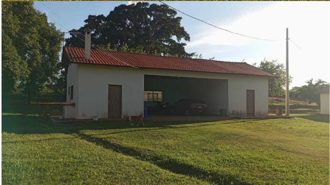
Garagem de veículos
