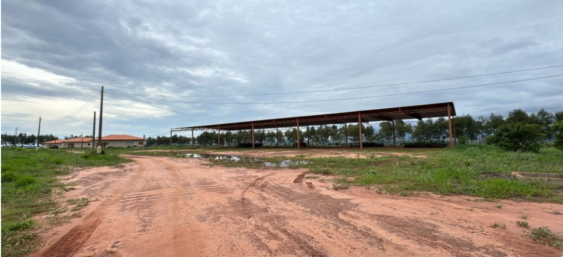
Barracão de Máquinas
