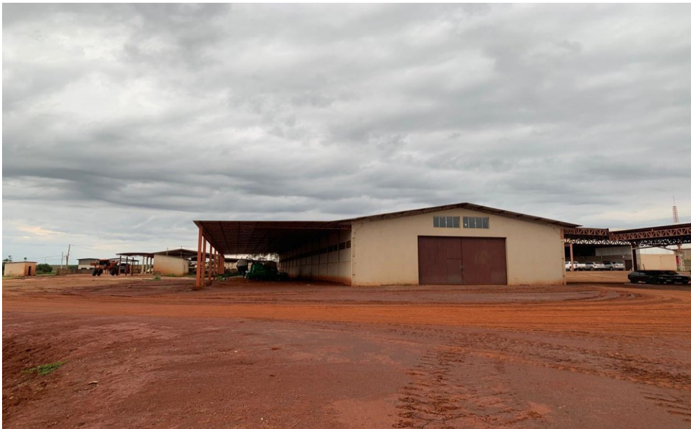
Barracão de Armazenamento de Madeiras
